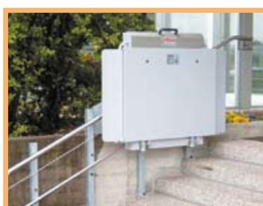
Protection anti-vandalisme assurée par le plateau relevé en position parking, boutons de commande non accessibles
