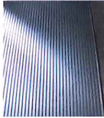
Tablier isolé galvanisé vernis
